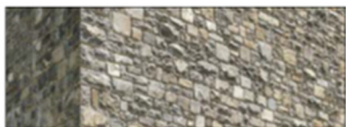
Mampostería concertada de piedra caliza de la zona.
